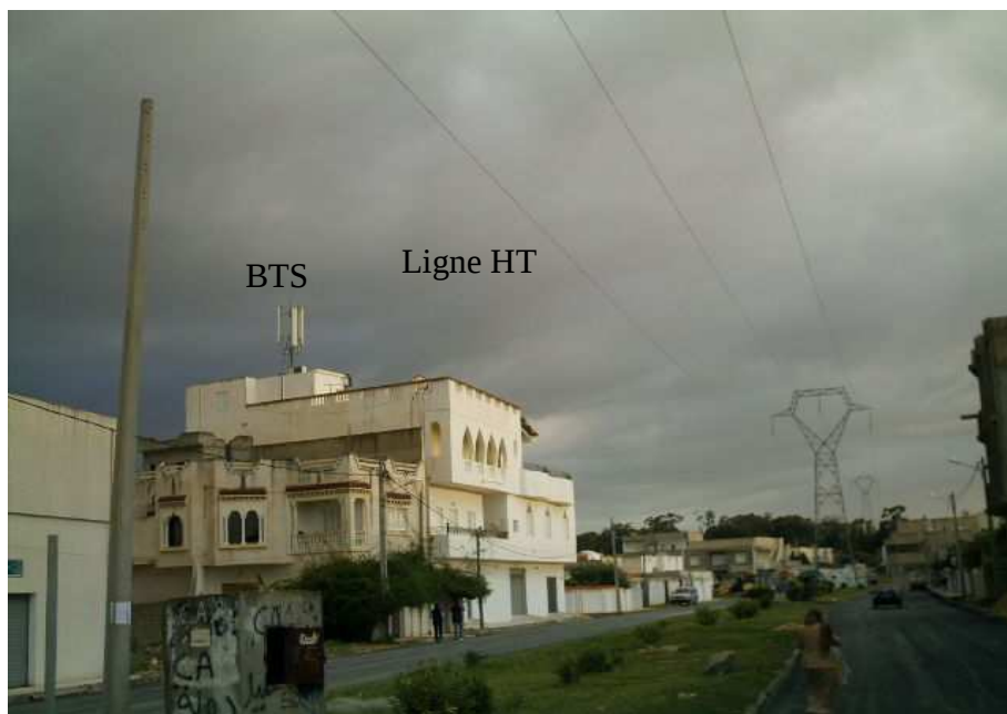
Figure 6. Exemple d'implantation à Radès de BTS aux voisinages d'une ligne 150kV ( d=20m )
